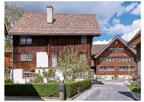
2 Die Gebäudeseite ist mit dem Rathaus (4) zusammen raumbildend. Das Dach wurde kürzlich mit Altziegeln saniert.
