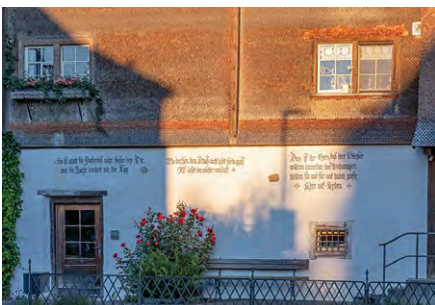
8 Aufgemalte Sprüche zieren das Erdgeschoss der Strassenfassade.
