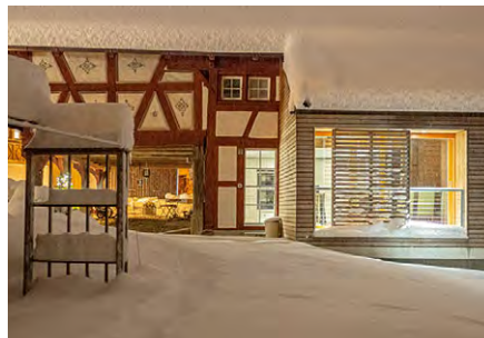
4 Nordseite Rathaus mit zeitgenössischem Anbau an das rückwärtige Wohnhaus.
