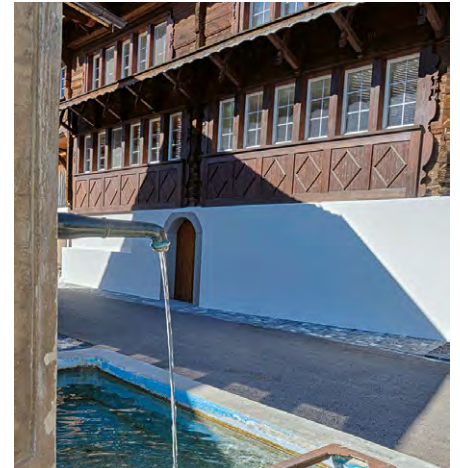
5 Gebäude mit rekonstruierter Hauptfassade an der Rathausstrasse.
