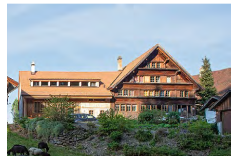
10 Bauernhaus mit zu Wohnzwecken umgebauter Scheune.
