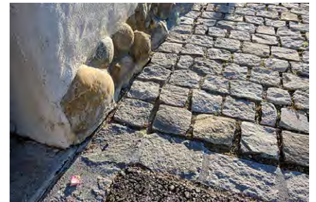
Sämtliche Pflasterungen wurden in Guberstein ausgeführt.
