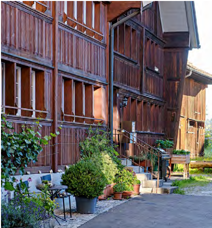
3 Raumbildende Fassadenflucht am Dorfplatz mit neu gepflastertem Vorbereich.
