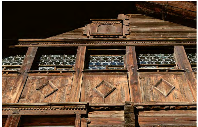
Die Fassade des Hauses 1632 im Bereich der Firstkammer.
